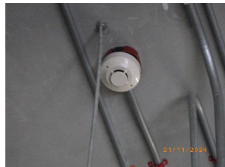
รูปที่ 2-46 เครื่องตรวจจับควัน (Smoke Detector) ภายในห้องหม้อแปลงไฟฟ้า
