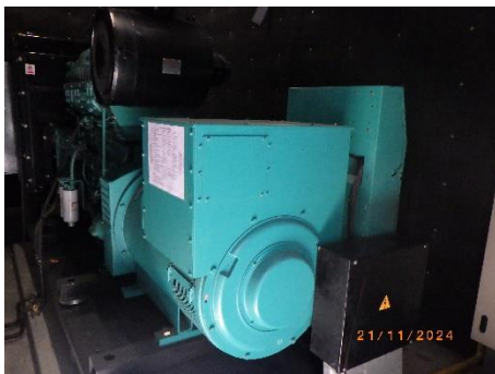
รูปที่ 2-45 เครื่องกำเนิดไฟฟ้า 300 KVA
