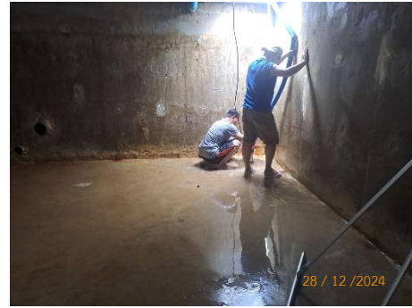
รูปที่ 2-26 การล้างทำความสะอาดถึงเก็บน้ำสำรอง
