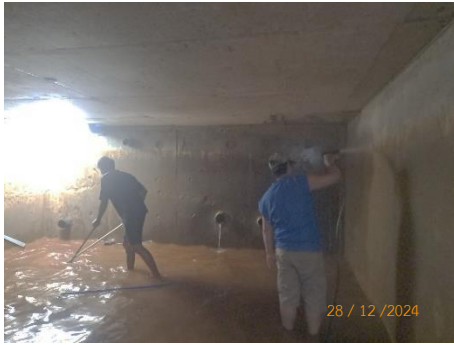
รูปที่ 2-26 การล้างทำความสะอาดถึงเก็บน้ำสำรอง
